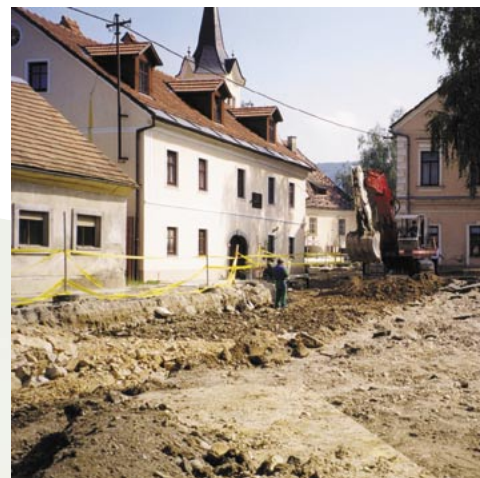
Obnova Kostanjevice na Krki.
